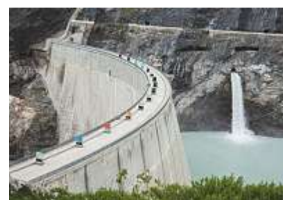
Le barrage de Mauvoisin VS. Foto: © Commune de Bagnes.
