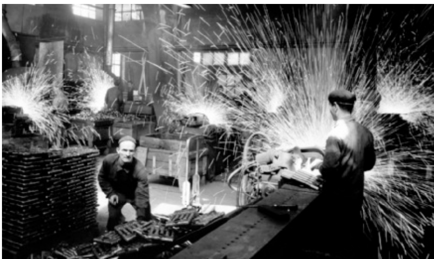
Blick in die industrielle Vergangenheit des Kantons Aargau: Schweißen von Radiatoren um 1939. Foto: Zehnder Group Schweiz AG, Gränichen
