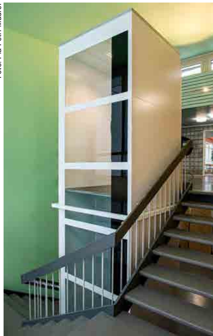
Die neu eingebauten Lifte fügen sich harmonisch in die bestehenden Treppenhäuser ein.
